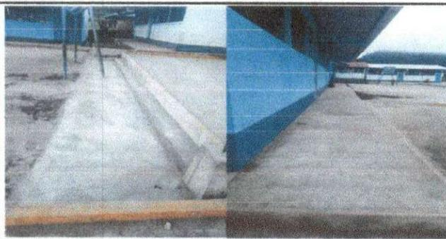
Foto 5: Sustitución de piso de torta de concreto (patio)
