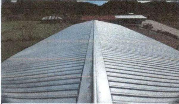
Foto1: sustitucion de lamina por lamina trquejada calibre 26 (modulo 1)
