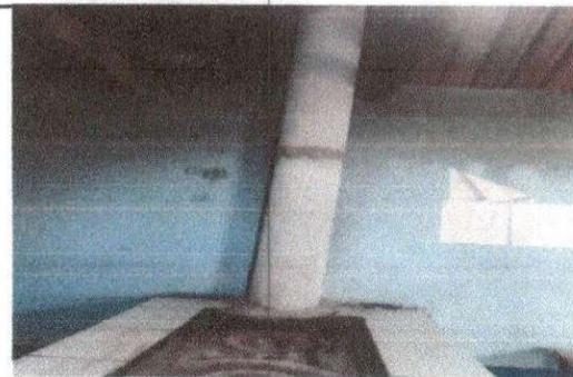
Foto 6: Sustitución de chimineas de metal por concreto
